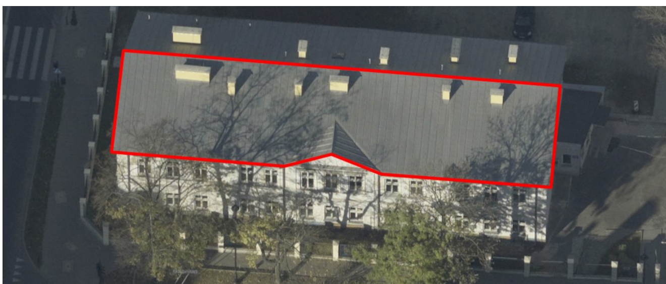
Rys. 5. Przykład dachu nie nadającego się do montażu paneli fotowoltaicznych ze względu na zacinienie powodowane przez rosnące od strony południowej drzewa – Lublin, ulica Radziwiłłowska 13, źródło: http://lotnicze.lublin.eu
