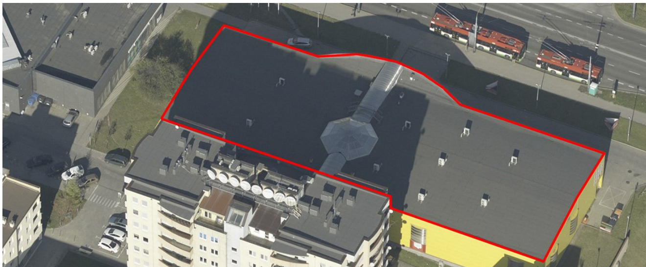
Rys. 4. Przykład dachu nie nadającego się do montażu paneli fotowoltaicznych ze względu na zacinienie powodowane przez inny wyższy budynek znajdujący od strony południowej – Lublin, ulica Zana 37, źródło: http://lotnicze.lublin.eu
