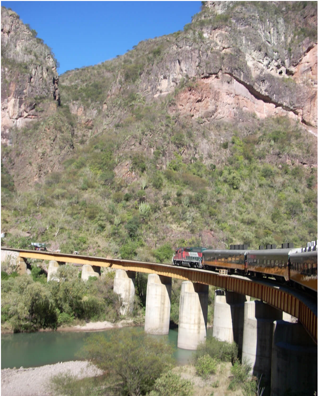
Fot. 11. Pociąg El Chepe na dystansie ok. 160 km wspina się na wysokość 2000 m n.p.m., pokonując przy tym 37 okazałych mostów i 86 tuneli.
