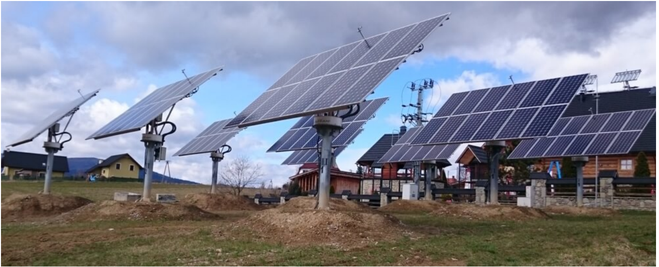
Fot. 1. Elektrownia słoneczna wyposażona w system nadążny za Słońcem.
