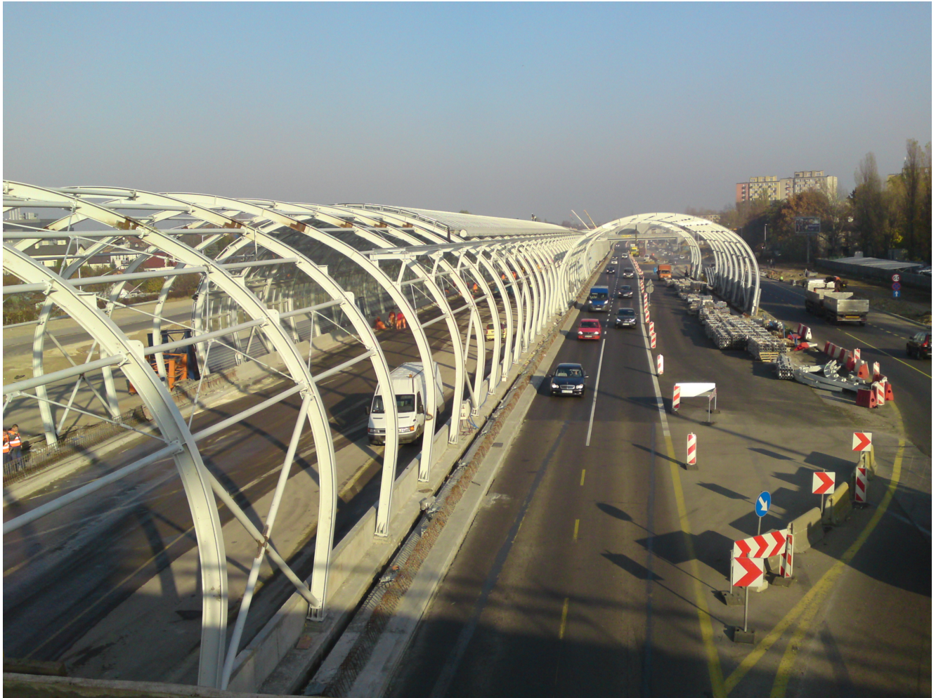
Fot. 1. Ekrany akustyczne półtunelowe w Warszawie.
